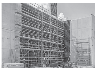
Pracovní lešení na staveništích
