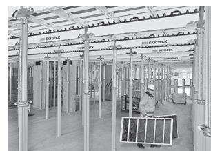
Stropní bednění
