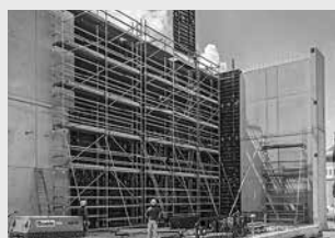
Pracovní lešení na staveništích
